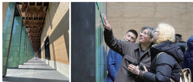
视觉盛宴与光影交错的组合：龙泉青瓷屏板、木装饰吊顶、夯土墙
