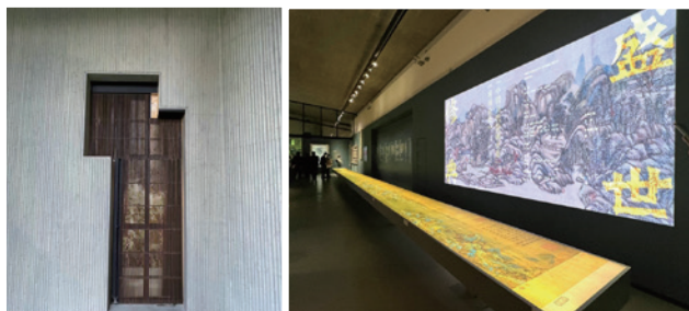
纹理细腻的竹纹清水混凝土
